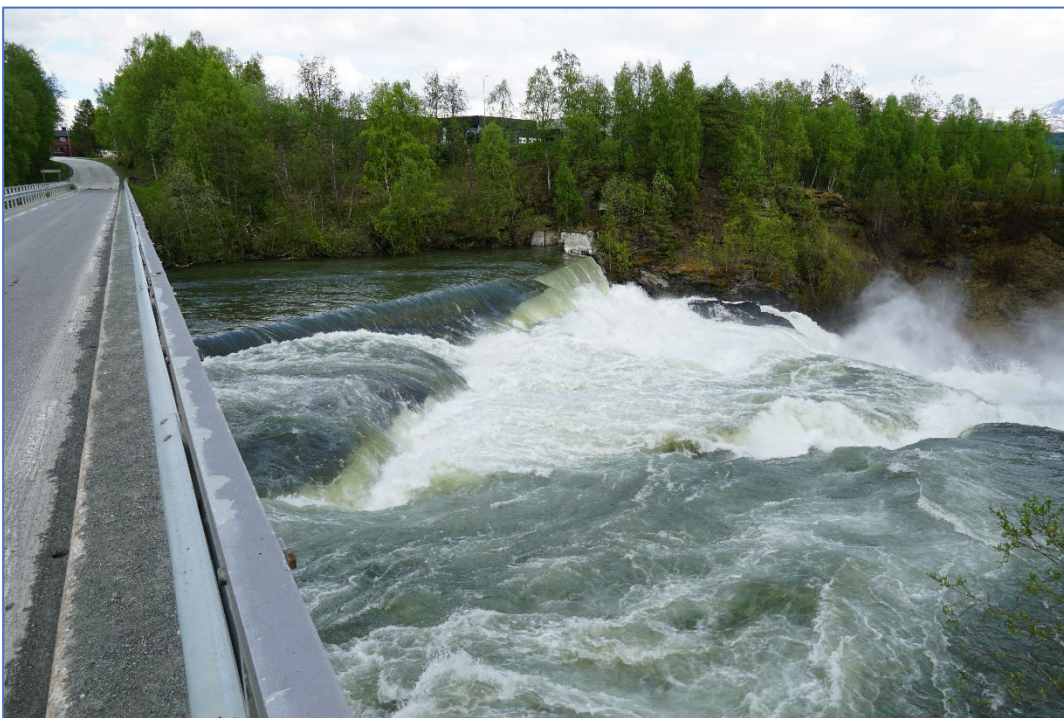
Figur 2: Bardufossen og demning (Bilde tatt av Norconsult 2022-06-03)
