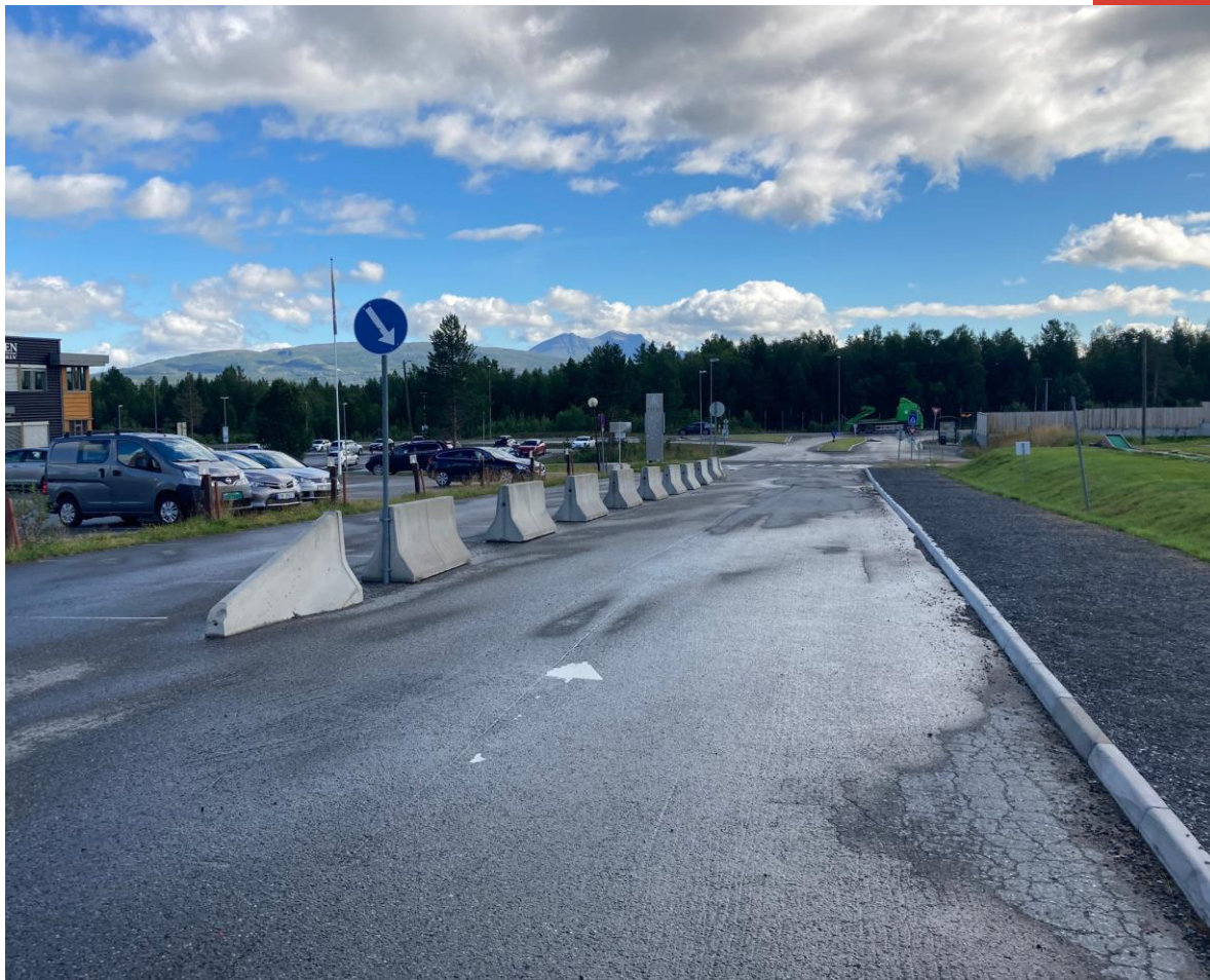
Figur 8 Eksisterende fortau ved Bardufoss videregående skole, Kilde: Befaring 18. 08.2022
