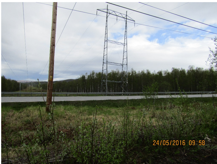
Figur 16 viser høyspentmast nær E6
