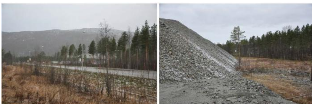
Figur 3-6 T.v.: Steinbruddet sett fra Målselvsveien (E6) er noe synlig, men bruddflaten filtreres gjennom trærne langs veien og dermed begrenses synligheten. T.h.: Avslutningen av bruddvirksomhet mot myra på Buktaemoen.
