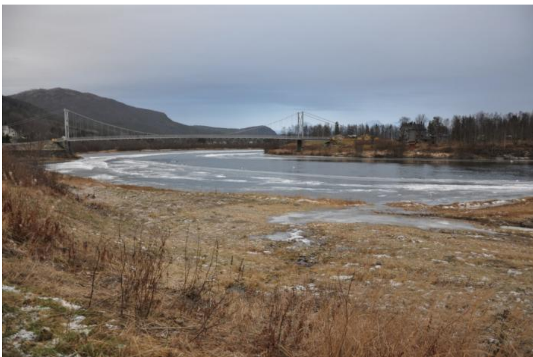
Figur 3-2 Broen ved Elvenes er en av to broer som krysser Målselva i delområdet, men uten at den visuelle kontinuiteten forstyrres i særlig grad.
